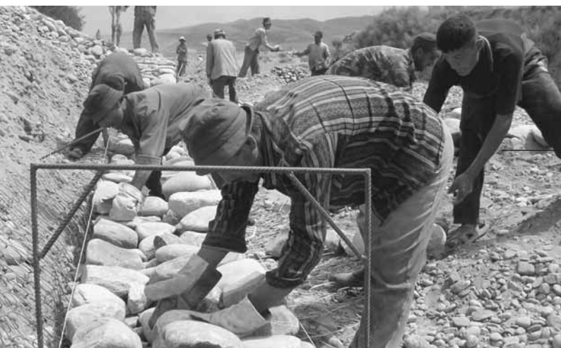
Comunidades locales de Muninabad, Tajikistán, participando en el mejoramiento de terraplenes de contención de la orilla de un río. (Foto: S. Eugster, COSUDE)
